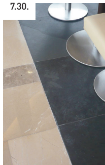
7.29. ÁBRA A fotón látható burkolati sáv, tapinthatóan érdes felülettel, kiválóan működne vezetősávként is. A keresztirányú sávokat úgy is ki lehetett volna osztani, hogy , azok üzletbejáratok előtt szakítsák meg a sötét bordúrt.
